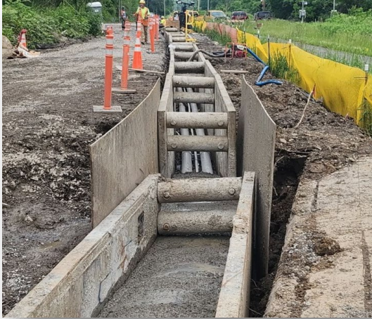
Dig Lay, Backfill
